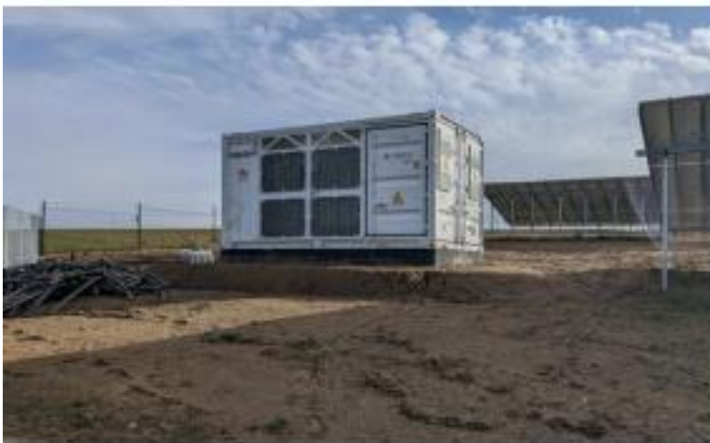
Figur 3-13. Foto eksempel på parktransformer. Kilde: Ecosolar.
